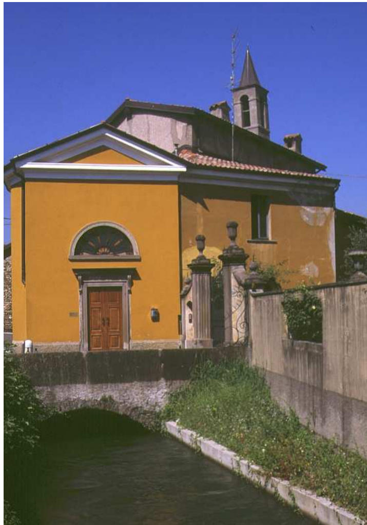
La chiesetta costruita su disegno del Pollak in Via Abbadia a Scanzo.
