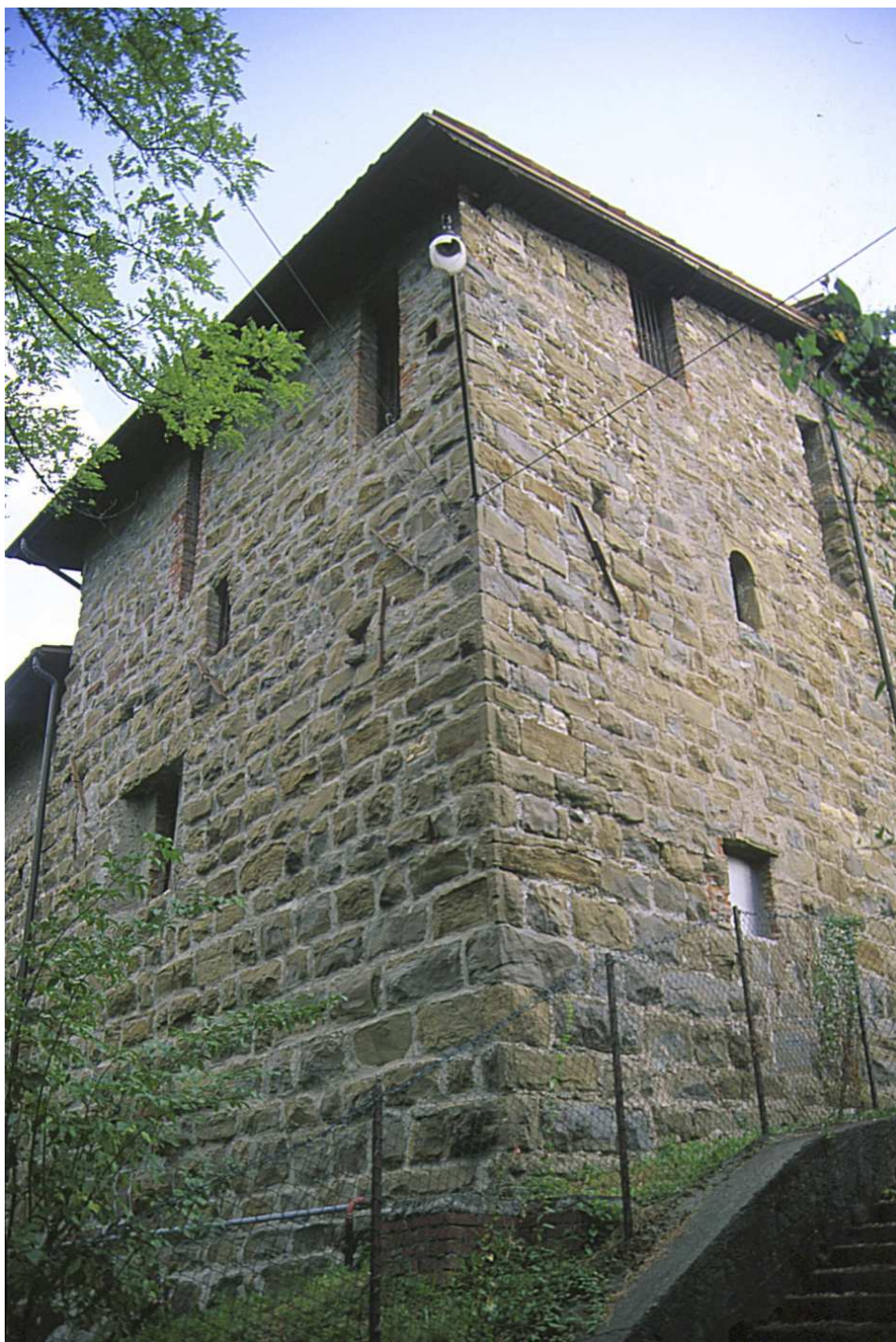
La torre del mastio del castello dei Rivola di Comonte, realizzata in massicci blocchi di pietra arenaria.
